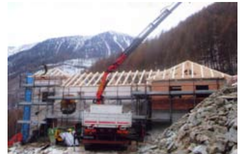
Der Dachstuhl mit Neuanbau
